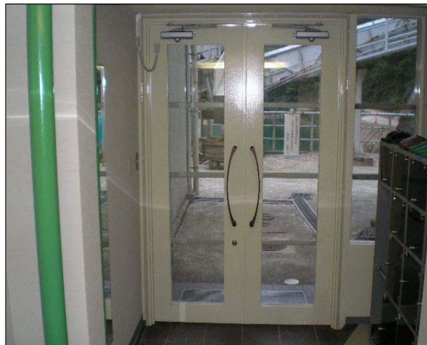
平成 20 年 9 月 18 日 ドア復旧 (平成 20 年 9 月 25 日) 撮影
