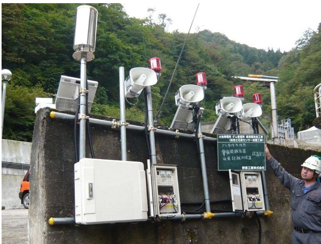
写真-8 土石流監視センサー・受信器設置状況
