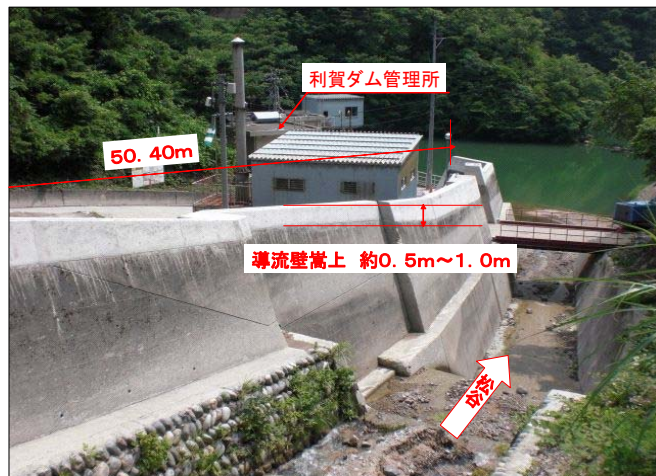
既設導流壁嵩上げ部分
