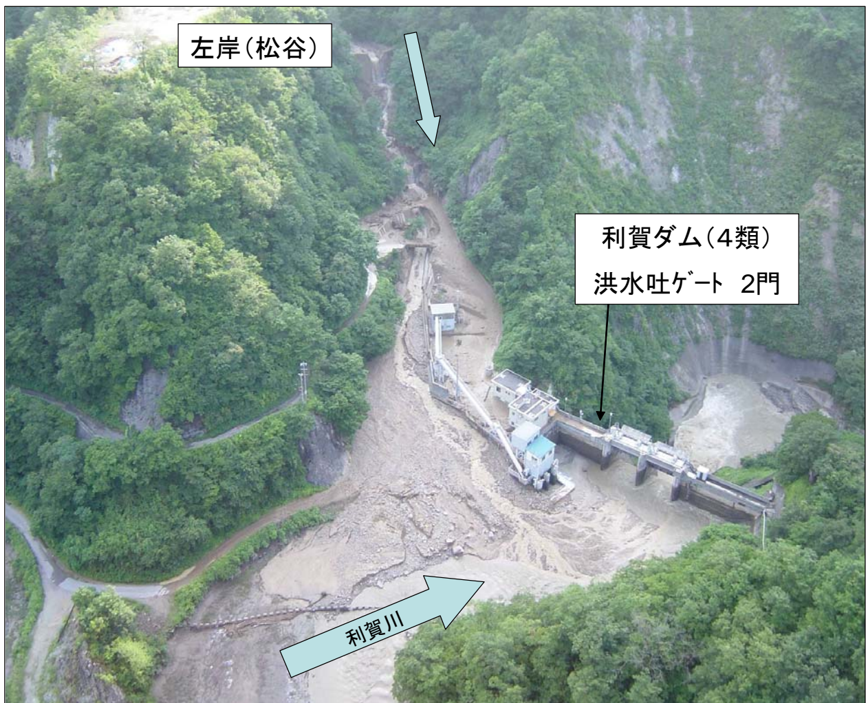
写真-1 利賀ダム 被災状況 平成 20 年 7 月 28 日 (土石流発生当日) 撮影
