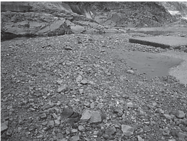
写真-1 豆谷ダム直下の河床の状況
