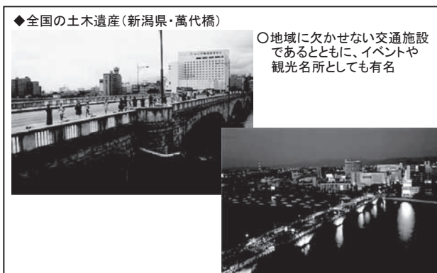
図-2 土木遺産活用例(新潟県・萬代橋)
